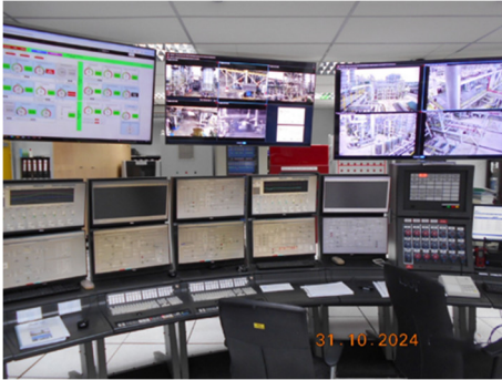
ภาพที่ 2.2-26 ระบบ Distributed Control System (DCS)
