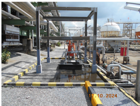
ภาพที่ 2.2-19 Slop Oil Tank รวบรวมเศษน้ำมันจากหน่วย CPI
