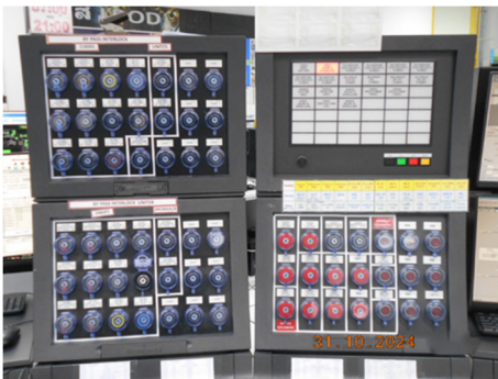
ภาพที่ 2.2-28 ระบบ Interlock System ควบคุมการจ่ายสารเข้าสู่ระบบ
