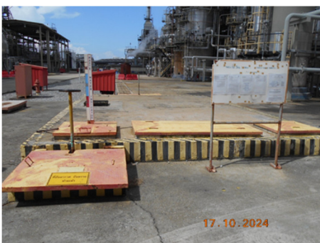
ภาพที่ 2.2-7 บ่อรับน้ำฝน และ บ่อ Oily Water
