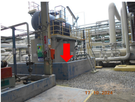
ภาพที่ 2.2-30 Band Wall ป้องกัน Tank pit
